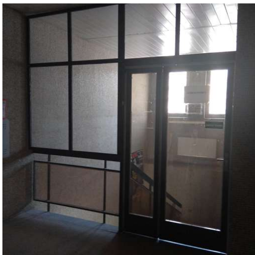
Obr.1: Stávající výplně otvorů – prosklená přička
